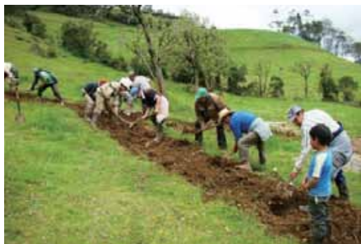
Faena de enterrado de tubería de distribución – La Lava
