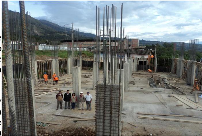
El terreno donde se está interviniendo la obra tiene una área de 1 634.40 metros cuadrados, de forma geométrica regular, la infraestructura a construir es de material noble, construida en base a pórticos de concreto armado y albañilería, la cimentación consta de zapatas corridas, unidas por vigas de cimentación de concreto armado, losa aligerada cubierta con teja andina, el sistema de piso lo constituye un falso piso, contra-piso y luego el piso de cerámico.
