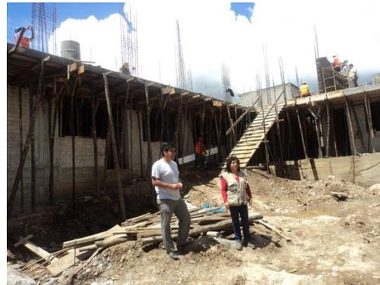
La obra consiste en la reconstrucción del local donde funciona la UGEL Cajabamba, para lo cual se ha demolido la construcción existente y se está construyendo una infraestructura de dos pisos para oficinas y auditorium, con techo aligerado a dos aguas, cobertura de teja andina, acabados básicos, implementación con mobiliario y equipos de cómputo.
