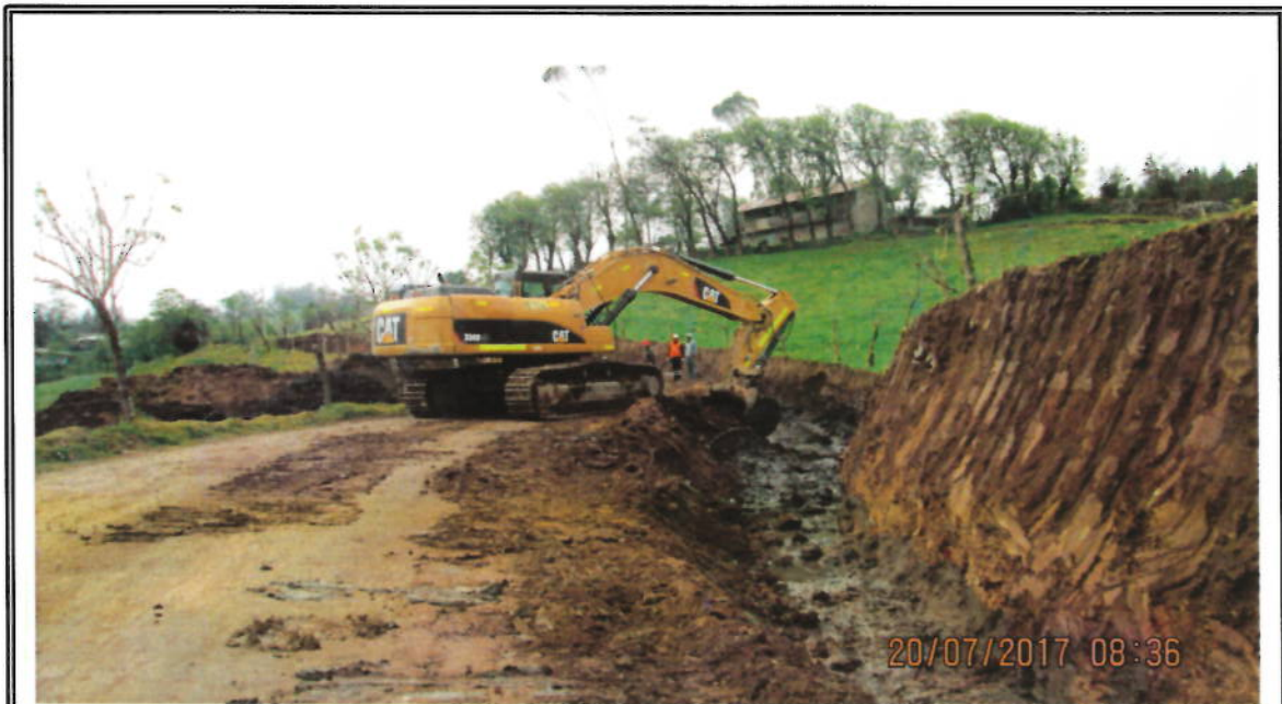
FOTO: SUPERVISION VERIFICANDO TRABAJOS DE CORTE EN MATERIAL SUELTO.
