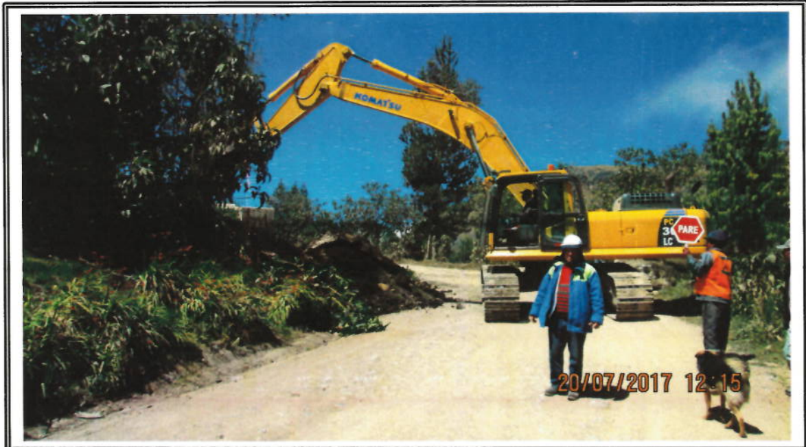
FOTO: SUPERVISION VERIFICANDO TRABAJOS DE ELIMINACION DE MOVIMIENTO DE TIERRAS
