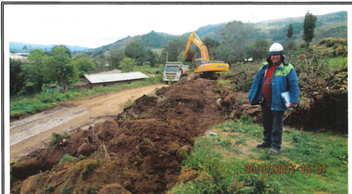
FOTO: SUPERVISION VERIFICANDO TRABAJOS DE DESANCHES DE LA CARRETERA.
