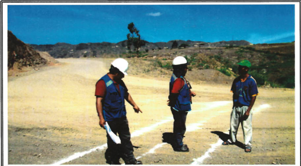
FOTO: SUPERVISION VERIFICANDO EN EL TRAZO Y REPLANTEO DE LAS ALCANTARILLAS.
