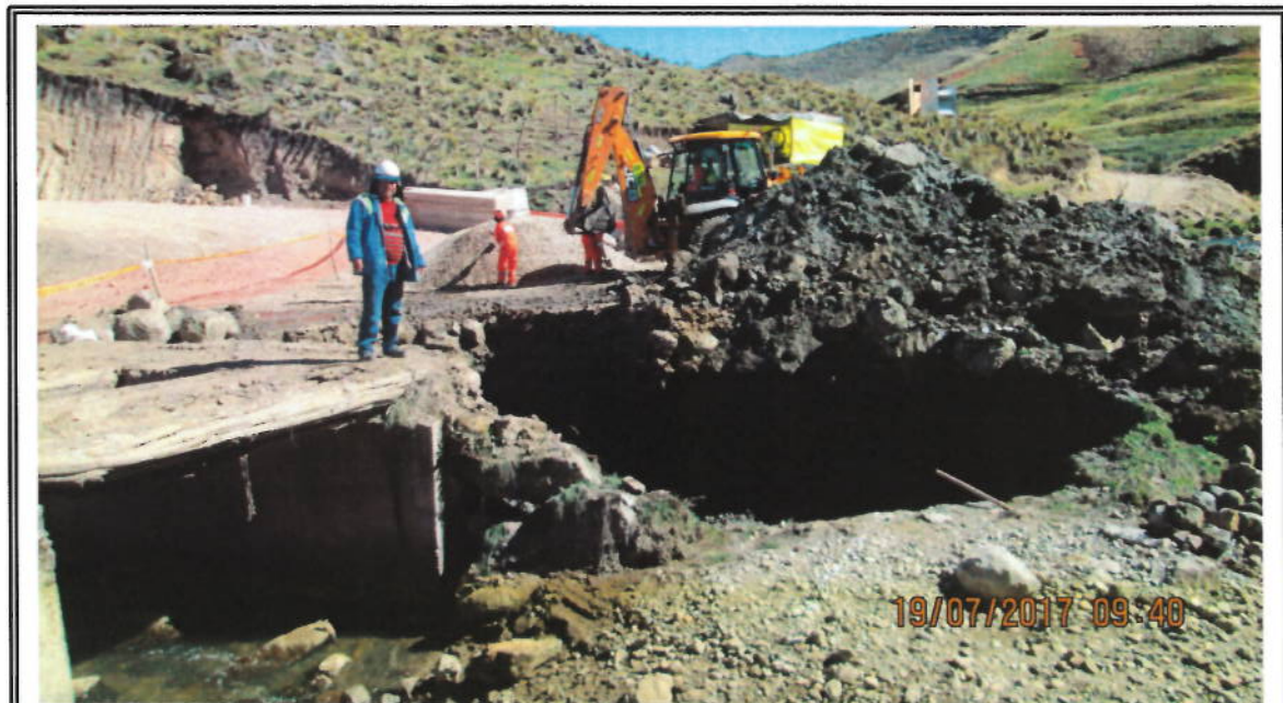
FOTO: SUPERVISION VERIFICANDO LOS TRABAJOS EN EL PONTON.
