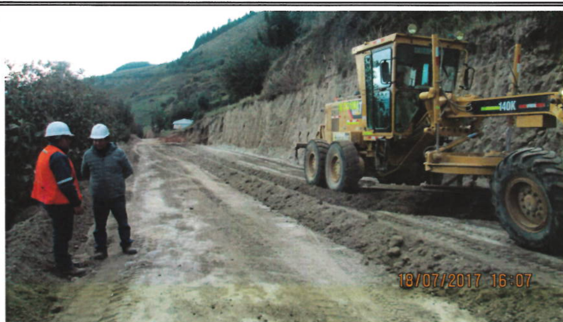
FOTO: SUPERVISION VERIFICANDO TRABAJOS DE MAQUINARIA EN EL DESANCHE DE LA CARRETERA.
