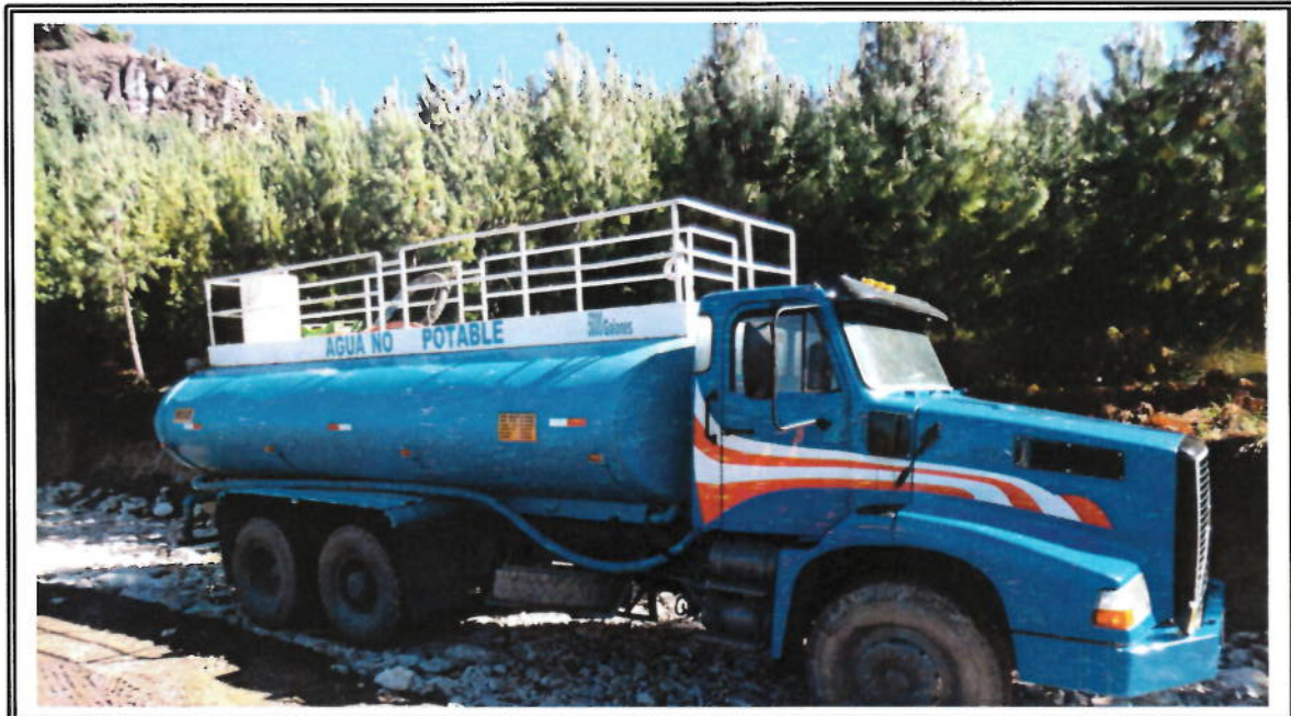
FOTO: SUPERVISION VERIFICANDO TRABAJOS DE TRANSPORTE DE AGUA PARA LA COMPACTACION DE MATERIAL DE AFIRMADO
