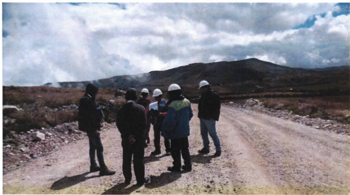
FOTO: SUPERVISION VERIFICANDO EL DESANCHE QUE CUMPLA SEGÚN EXPEDIENTE TECNICO.
