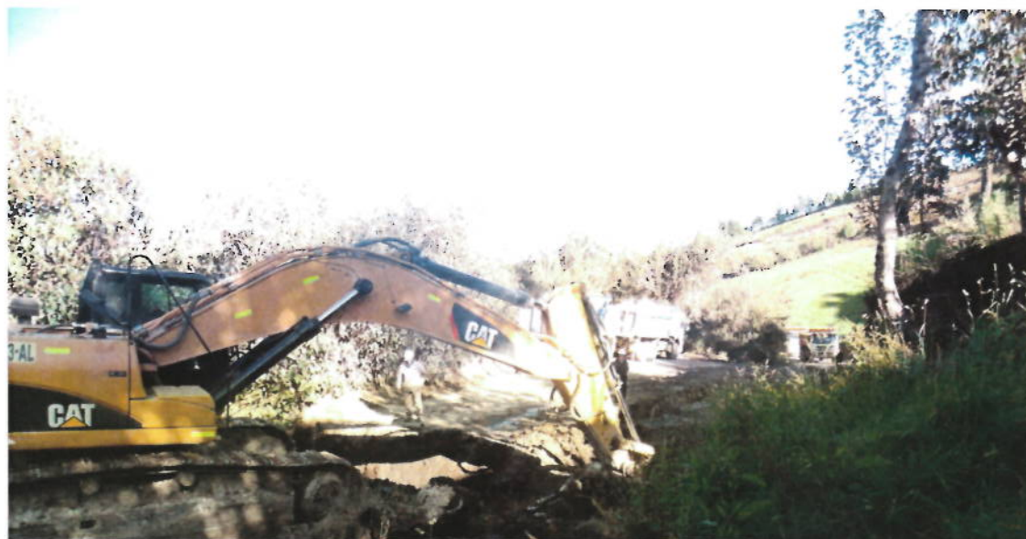
FOTO: SUPERVISION VERIFICANDO TRABAJOS DE CORTE EN MATERIAL SUELTO.
