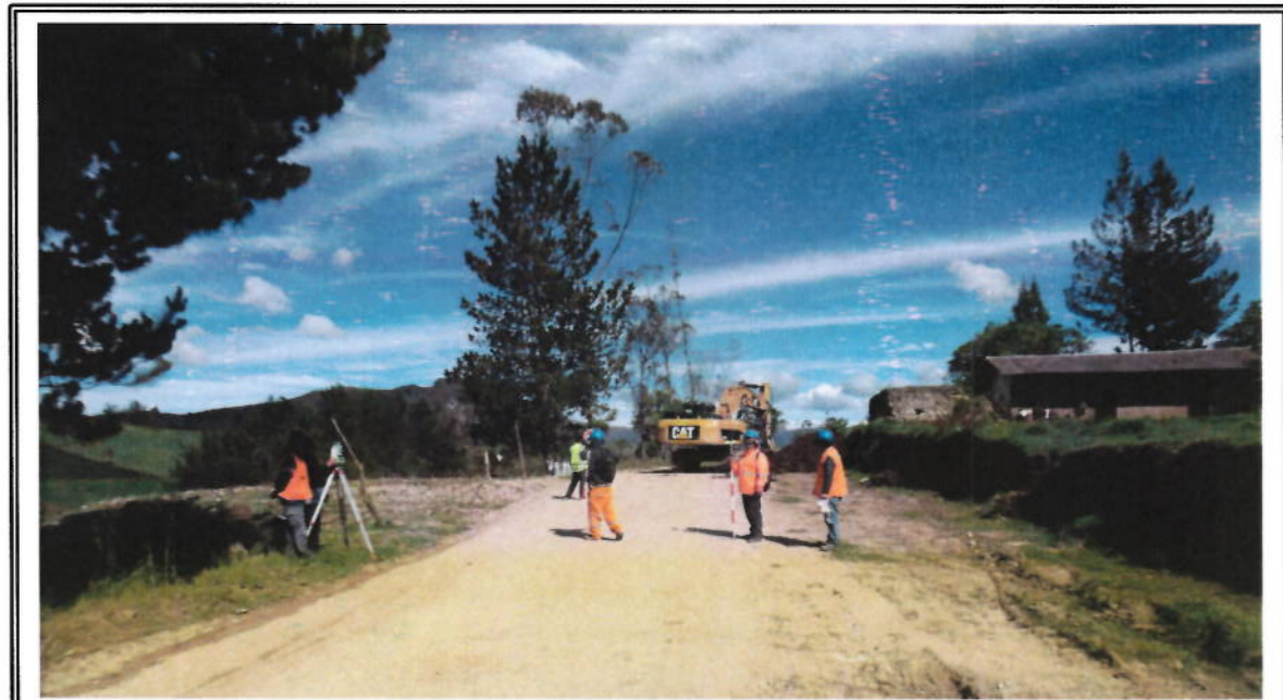
FOTO: SUPERVISION VERIFICANDO TRABAJOS DE TOPOGRAFIA EN TRAZO Y REPLANTEO.
