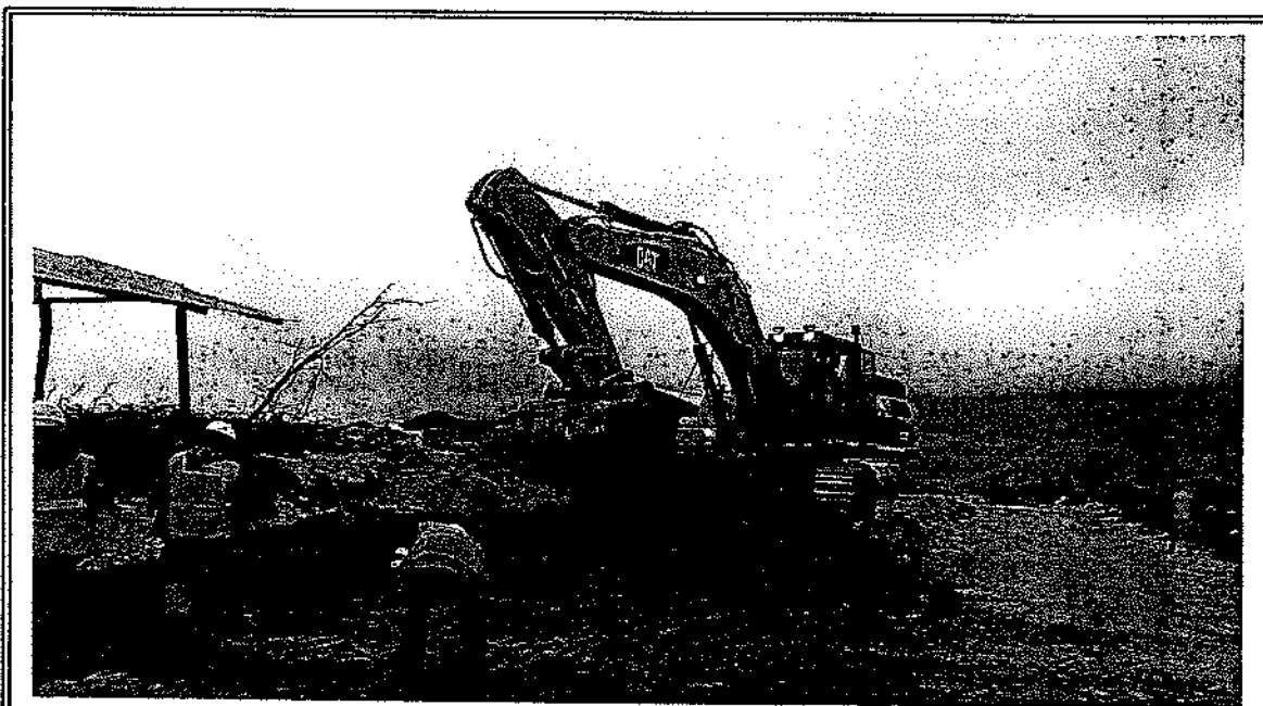
FOTO: SUPERVISION VERIFICANDO TRABAJOS DE MOVIMIENTO DE TIERRAS: CORTE EN TERRENO SUELTO
