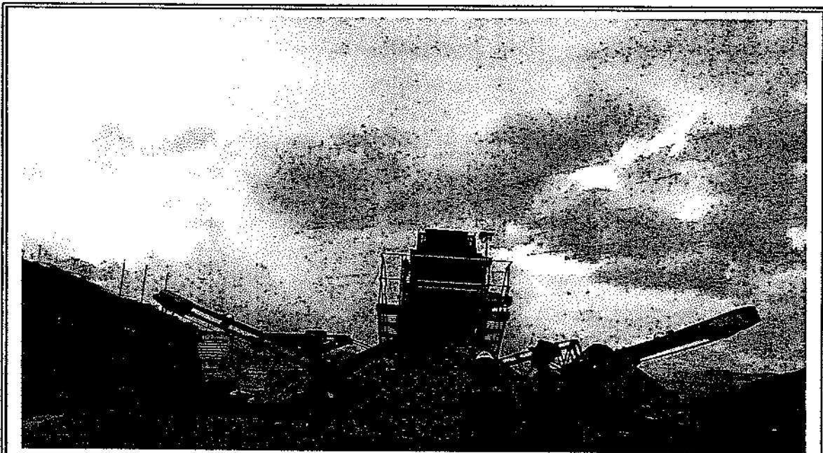
FOTO: SUPERVISION VERIFICANDO CANTERA QUEBRADA HONDA, SE EVIDENCIA FALTA DE PRODUCCION DE AGREGADOS.
