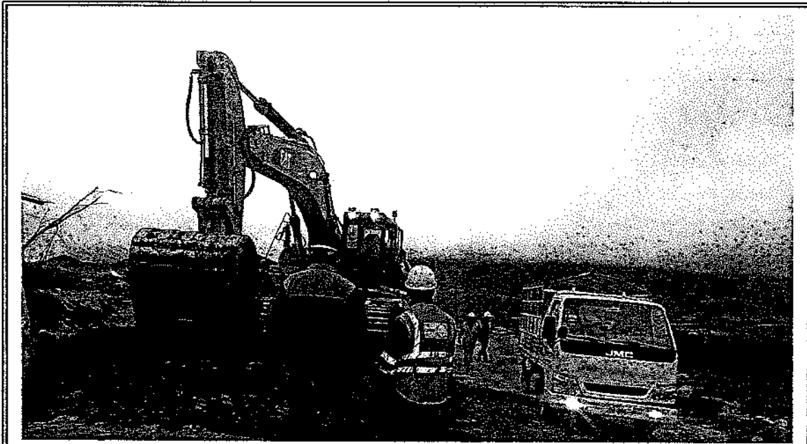
FOTO: SUPERVISION VERIFICANDO TRABAJOS PRODUCCION AGREGADOS CANTERA SANTA CRUZ KM 4.5 CARRETERA A CHICLAYO
