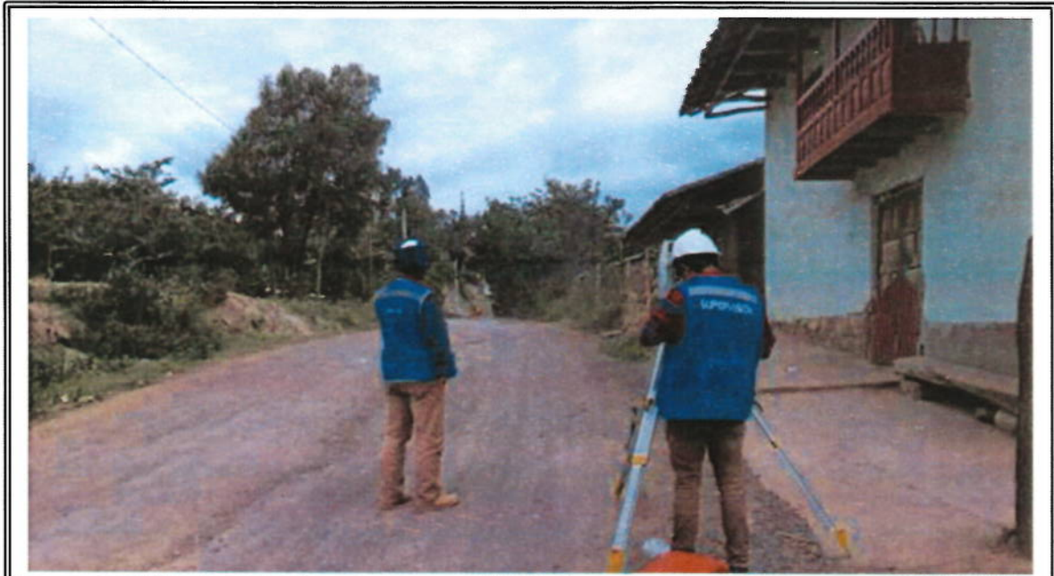
FOTO: SUPERVISION VERIFICANDO TRABAJOS REPLANTEO KM 2+00 HASTA KM 10+00
