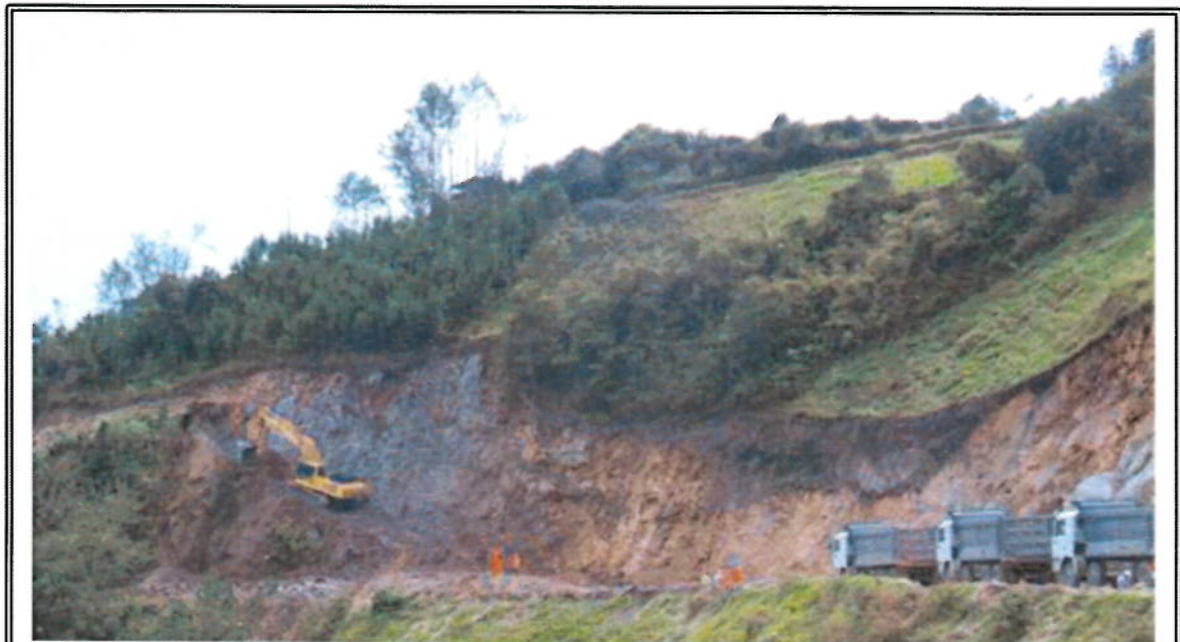
FOTO: SUPERVISION VERIFICANDO TRABAJOS DE MOVIMIENTO DE TIERRAS
