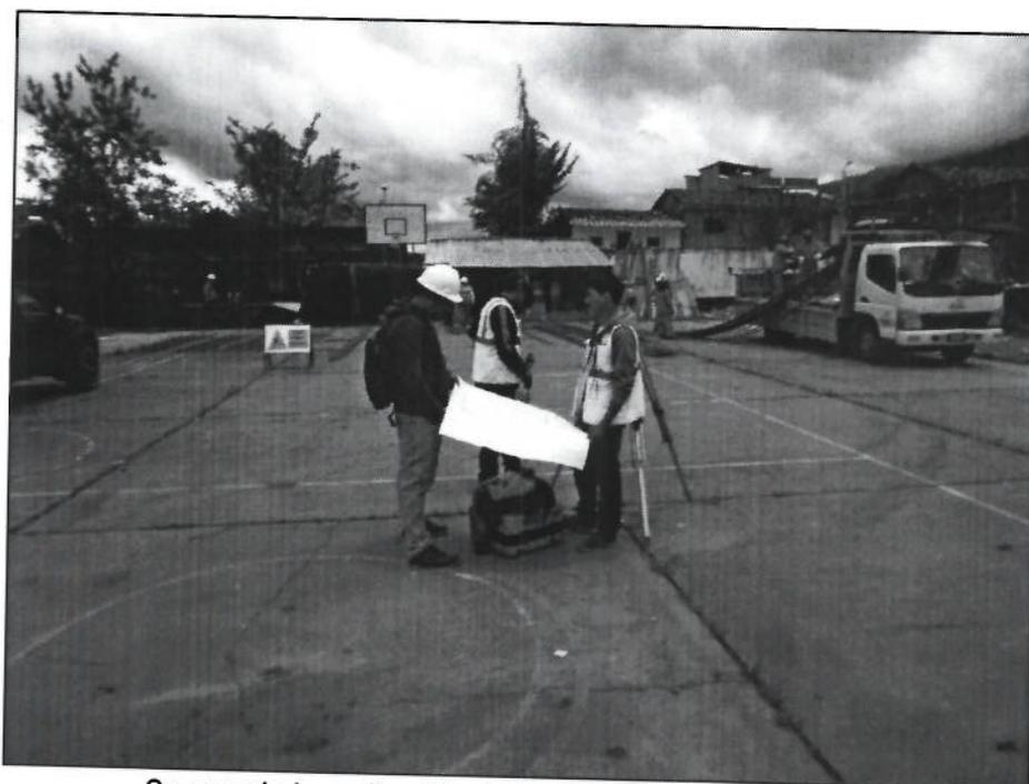
Se aprecia la realización del trazo y replanteo en obra
