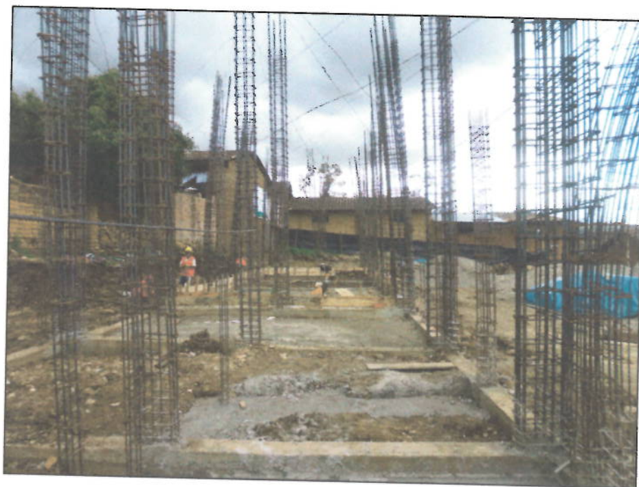
Vista panorámica de las columnas en el módulo II
