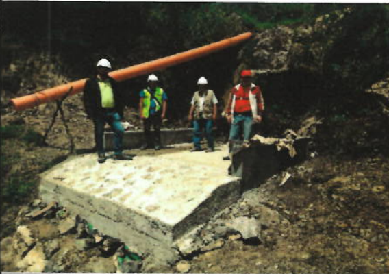
Foto N°01. Verificación de construcción de cruce de quebradas N° 01 en canal con tubería en compañía de Coordinador y Residente de Obra.
