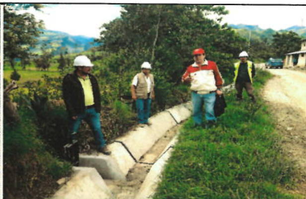
Foto N°02. Verificación de juntas de contracción y dilatación, toma lateral con compuerta tipo tarjeta y culminada en canal trapezoidal en compañía de Coordinador y Residente de Obra.
