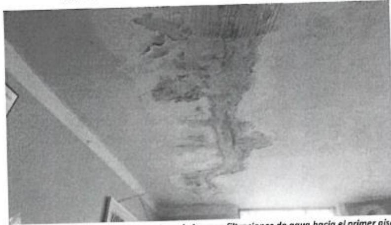
Fotografía N° 5: Se aprecia en la imagen filtraciones de agua hacia el primer piso
