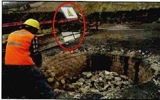
Foto N° 1: barandas de seguridad en defectuosas condiciones
