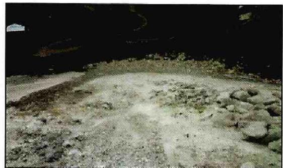
Foto N° 5: Desmontera con defectuosa estabilidad física.
