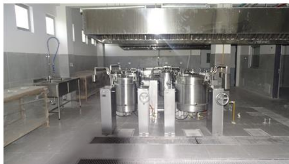
EQUIPO DE COCINA INSTALADO MARMITAS AUTOVOLCABLES
