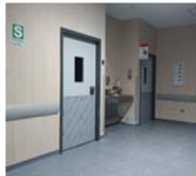
PUERTA METALICA DE ACERO INOXIDABLE (11.20 x 2.10 M) - SIST. CORREDIZO EN QUIROFANOS Y AISLADOS UCI-UCIN
