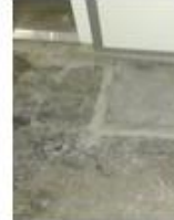
PISO DE CEMENTO PULIDO ACABADO NO UNIFORME CAMARA & DE CONGELACION
