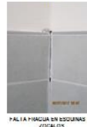
FALTA PUNTA EN ESQUINAS DE ZOCALOS
