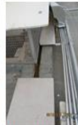
VINILICO EN PISO MAL COLOCADO, TAPAJUNTA MAL INSTALADA
