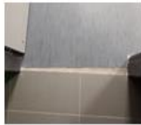
PLATINA DE ALUMINIO 5.8" X 1/16" EN PISOS
