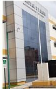
REVESTIMIENTO DE PACHADA CON ALUMINIO COMPUESTO Y CRISTAL FIBRADO EN PACHADA CON SILENCIO MECÁNICA
