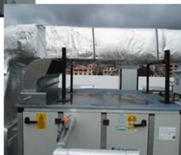
Estado actual de la lana de vidrio del aislamiento
