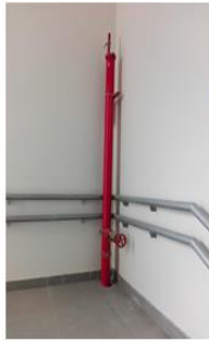
Sistema de agua fría sin anclajes
