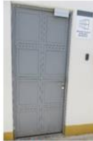
CAMBIO DE PUERTA DE PF-4 A P-20 ,EN TODO ALMACENES Y SALUD AMBIENTAL.
