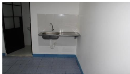
INSTALACION DE LAVADERO (17-08-2017)
