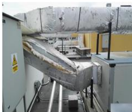
Estado actual de la lana de vidrio del aislamiento
