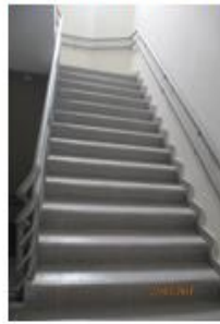
REVESTIMIENTO DE CERRAJES Y ESCALERAS, CON PORCELANATO 40 cm x 40 cm. ANTIRESLICANTE
