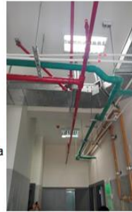
Sistema de agua fría sin anclajes
