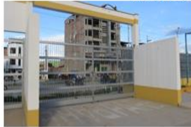
VENTANA METALICA TIPO REJILLA CON PLATINA DE P= 1" x 1/8"
