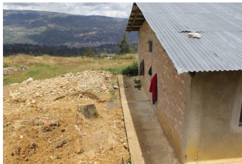
BIODIGESTOR PUESTO DE SALUD RAMBRAM PATA (18-08-2017)
