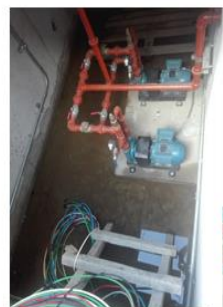
Instalaciones de bomba de trasiego de diésel generadores
