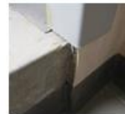
MAL ACABADO DE VINILICO EN ESQUINAS
