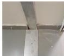
TAPA JUNTA DE ALUMINIO PLT. 4"X 6/8" CIBORDES DE GOMA UNICOLOR EN MURO, 710 COLUMNA Y/O PLACA
