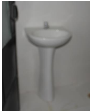
MEJORAMIENTO DE SERVICIOS HIGIENICOS (17-08-2017)
