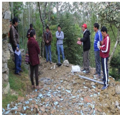
RESIDENTE Y SUPERVISOR DE OBRA (16-08-2017)
