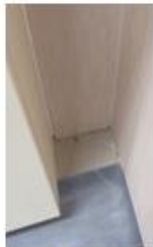
VINILICO EN PISO MAL COLOCADO, TAPAJUNTA MAL INSTALADA
