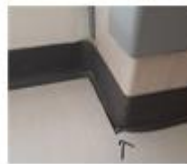
PISO DE PORCELANATO PIEZA & CON GRIETA &
