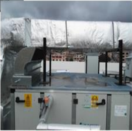
Estado actual de la lana de vidrio del aislamiento
