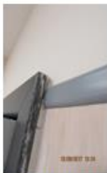
VINILICO EN PISO MAL COLOCADO, TAPAJUNTA MAL INSTALADA
