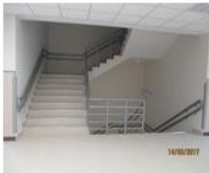
CONTRAZOCALO DE VINILICO SEMIRIGIDO, MAL INSTALADO
