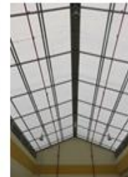
COBERTURA DE POLICARBONATO CON FILTRACIONES
