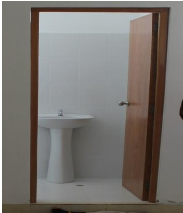
MEJORAMIENTO DE SERVICIOS HIGIENICOS (18-08-2017)
