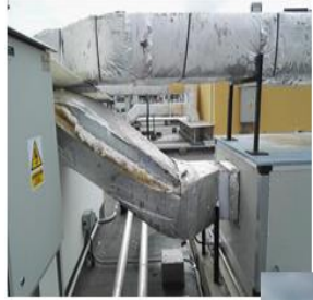
Estado actual de la lana de vidrio del aislamiento
