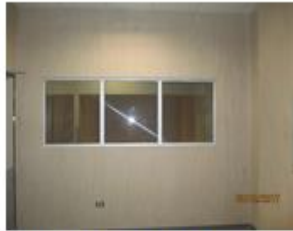
VENTANA DE ALUMINIO. TIPO FUGO CON CRISTAL RESISTENTE AL FUEGO 2 Hrs. 6 mm. INC ACCESORIOS
