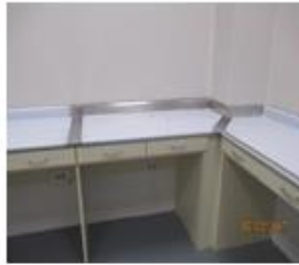
MUEBLES M-3 Y M-4, QUE SON DESMONTADOS POR MALA EJECUCION DE ZOCALOS VINILICOS EN PATOLOGIA CLINICA Y ANALOGIA PATOLOGICA
