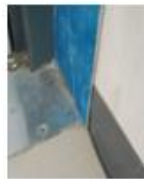
TAPA JUNTA DE ALUMINIO PLT. 4"X 6/8" CIBORDES DE GOMA UNICOLOR EN MURO, 710 COLUMNA Y/O PLACA
