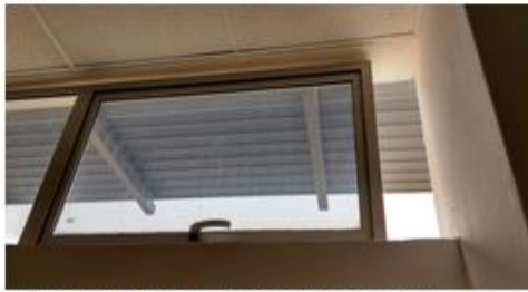
VACIOS EN LADO SUPERIOR, SE DEBENTARA PARA ANCLAJE ADECUADO
