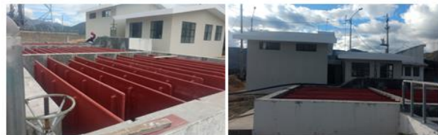
FOTO 01, 02: SE OBSERVA LOS TRABAJOS EJECUTADOS EN LA PTAP
