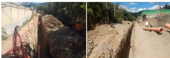
FOTO 07, 08: TRABAJOS DE SUMINISTRO E INSTALACION DE TUBERIA DE PVC
