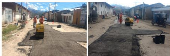
FOTO 05, 06: TRABAJOS DE COMPACTADO DE LA CARPETA ASFALTICA EN LA AVENIDA 28 DE JULIO
