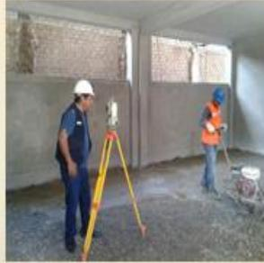
VERIFICACIÓN DEL ENCRADO DE LA LOSA ALIGERADA DE UNA DE LAS AULAS DEL MODULO A, PABELLÓN 1
