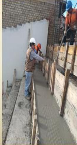
ENCOFRADO Y VACIADO DE COLUMNAS DE SOPORTE DE LA ESTRUCTURA METÁLICA DEL TECHO DE LA PATAFORMA DEPORTIVA, UBICADAS EN LA PARTE PERIMETRAL DE LAS GRADERIAS DEL MODULO "D"
