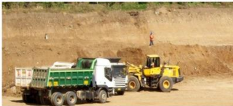
Construcción de planta de aguas residuales - Jaén
