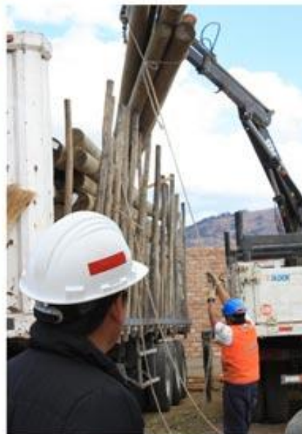
Carga de camiones en almacén de Cajamarca
