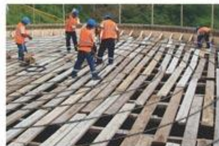
Construcción de reservorio de agua potable
