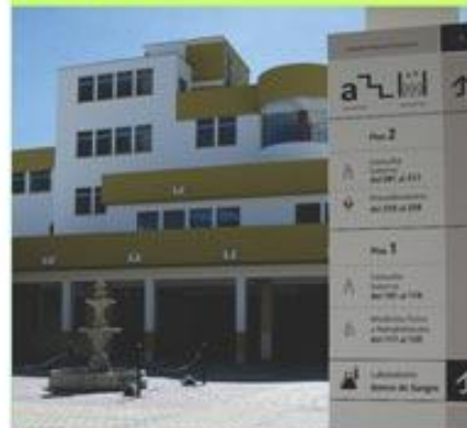
2do piso de las nuevas instalaciones del Hospital
