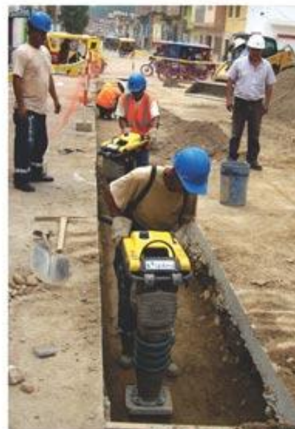
Instalación de redes de agua potable
