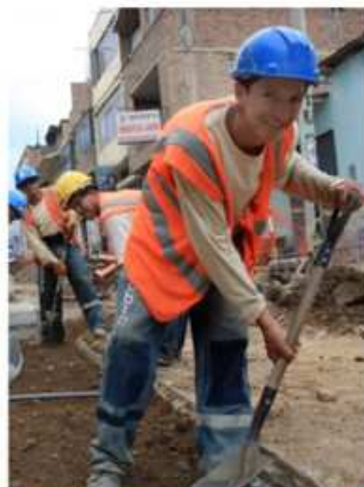
Frente de trabajo para el cambio de redes de agua potable
