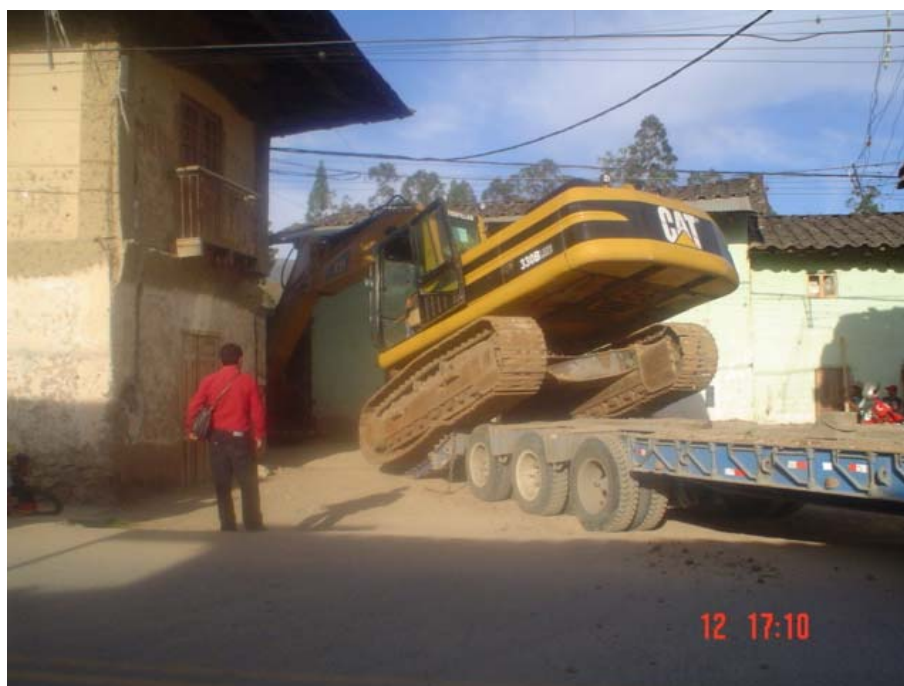
TRASLADO DE LA EXCAVAORA 330 A LA ZONA DE TRABAJO
